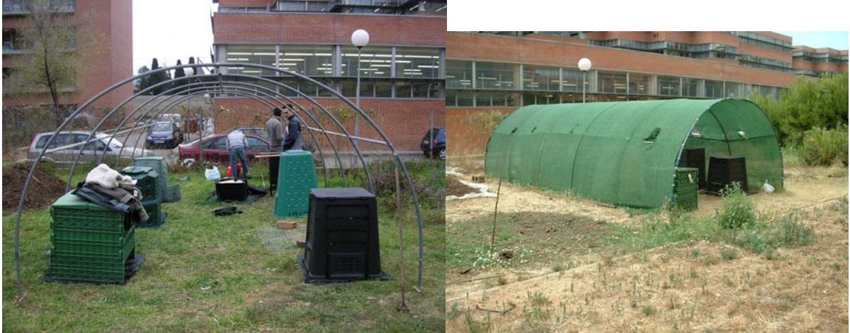
Ilustración 1. Fotografías del sistema de sombreado. A la izquierda, momento del montaje; a la derecha, el sistema definitivo
